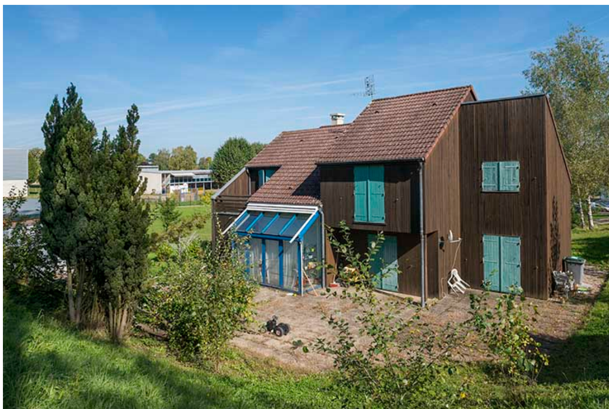
Façade postérieure sud-ouest du pavillon du directeur.
