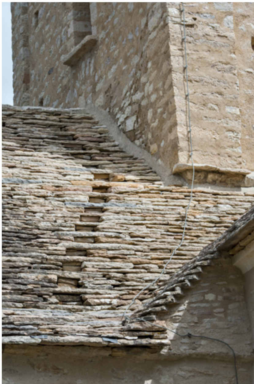
Marches sur le toit de la nef.
