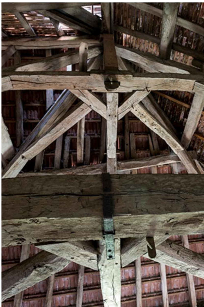
Poutrage du grenier de la chapelle
