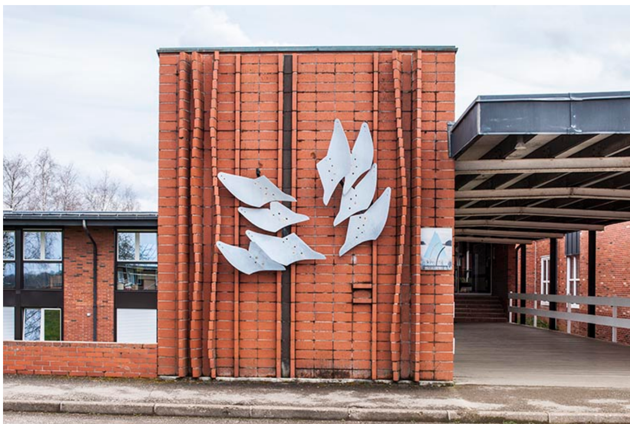
Mur nord vu de face.
