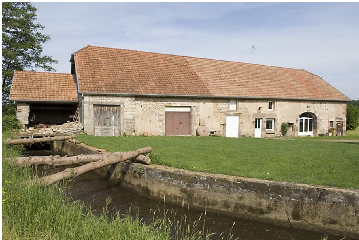
Bief d'amenée et façade antérieure.
