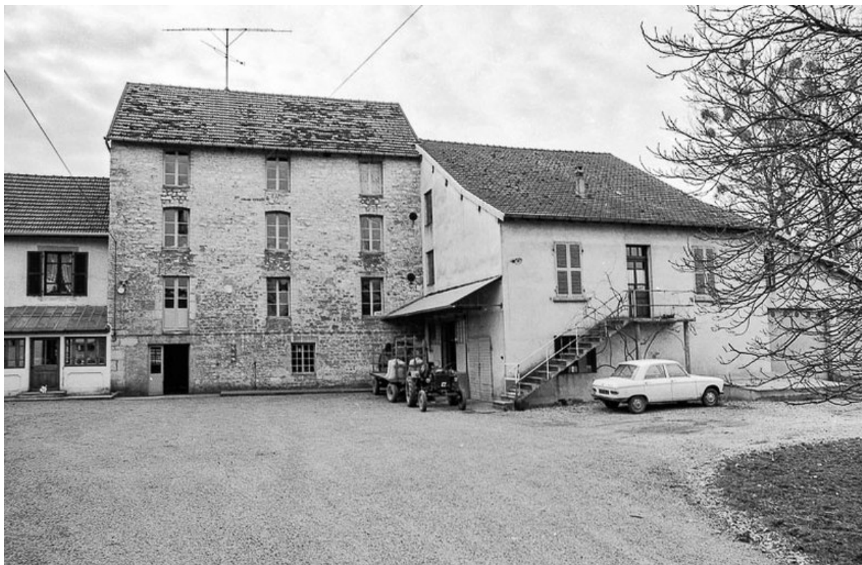
Façade nord du moulin et magasin industriel en 1979.
