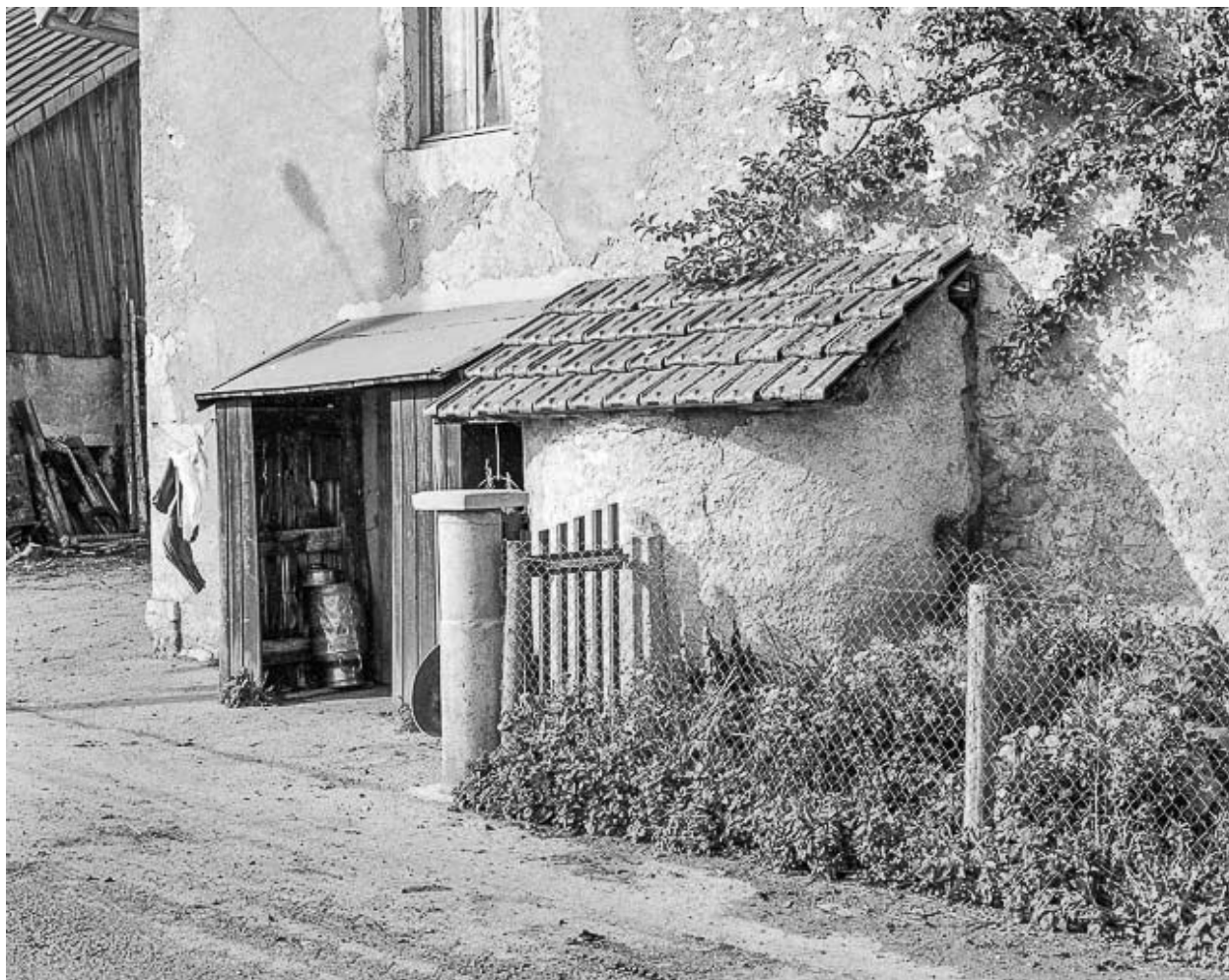
Ferme située à Fourcatier : le cul-de-four.
