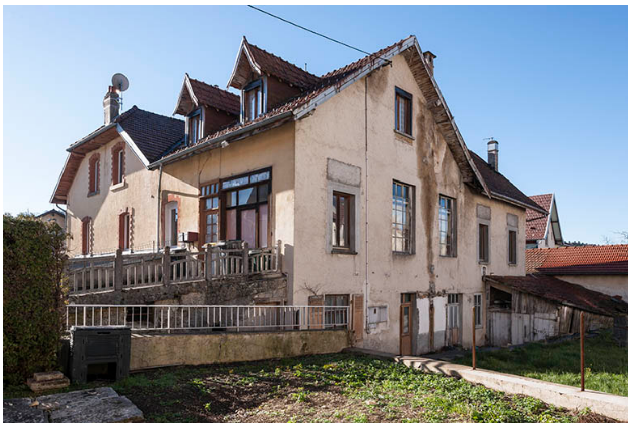
Façades postérieure et latérale droite.
