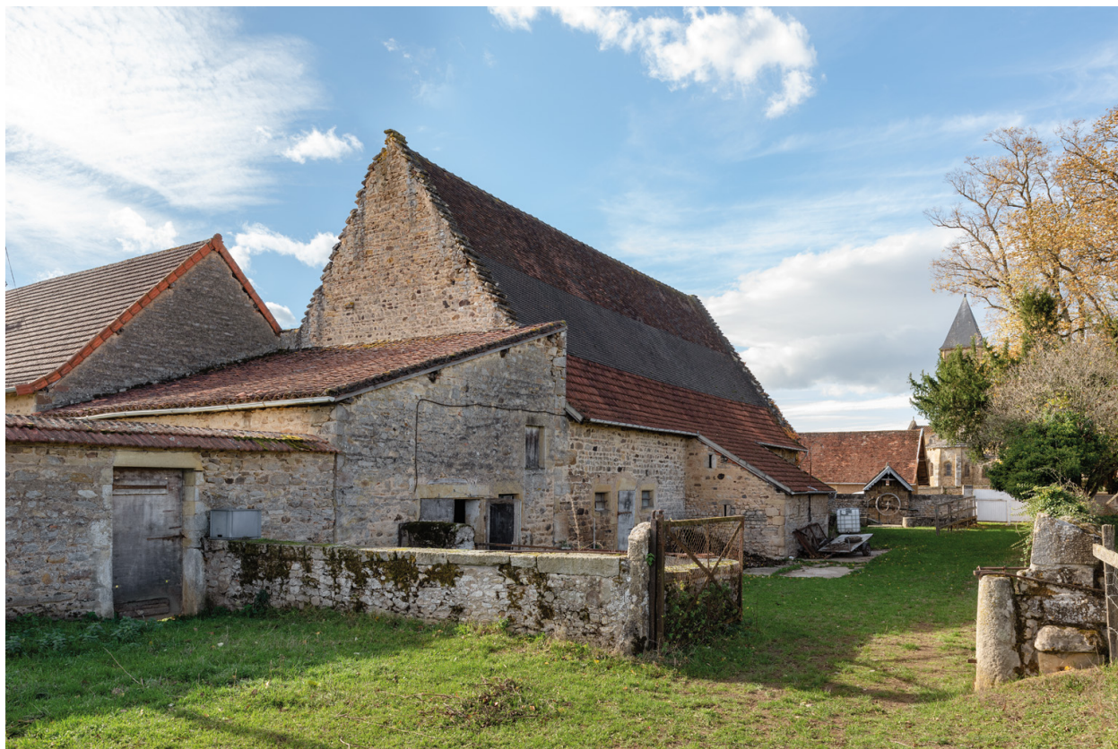
Façades postérieures des bâtiments agricoles.
