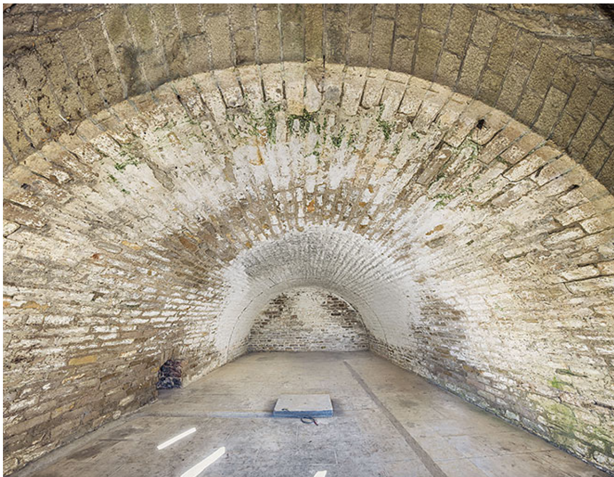
Vue intérieure de la traverse.
