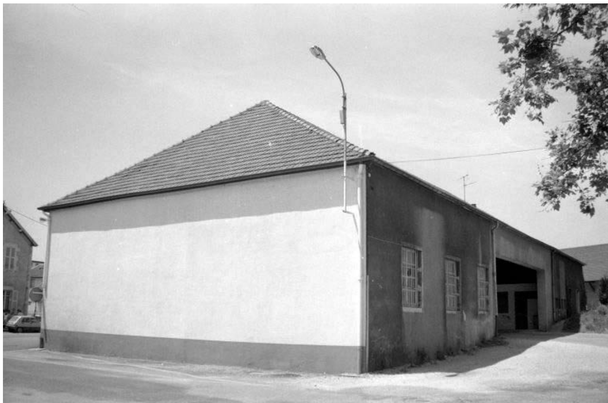
Façades postérieure et latérale droite.
