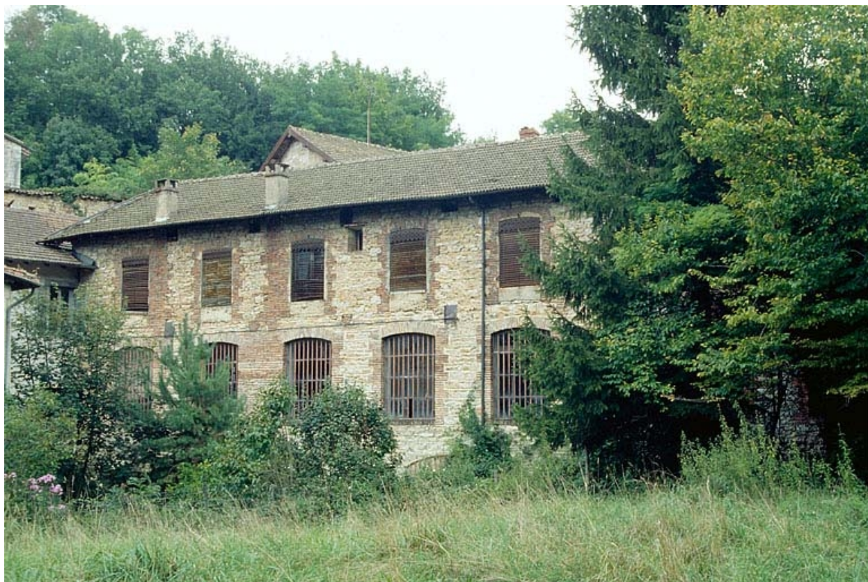
Atelier de fabrication (N) vu du sud.
