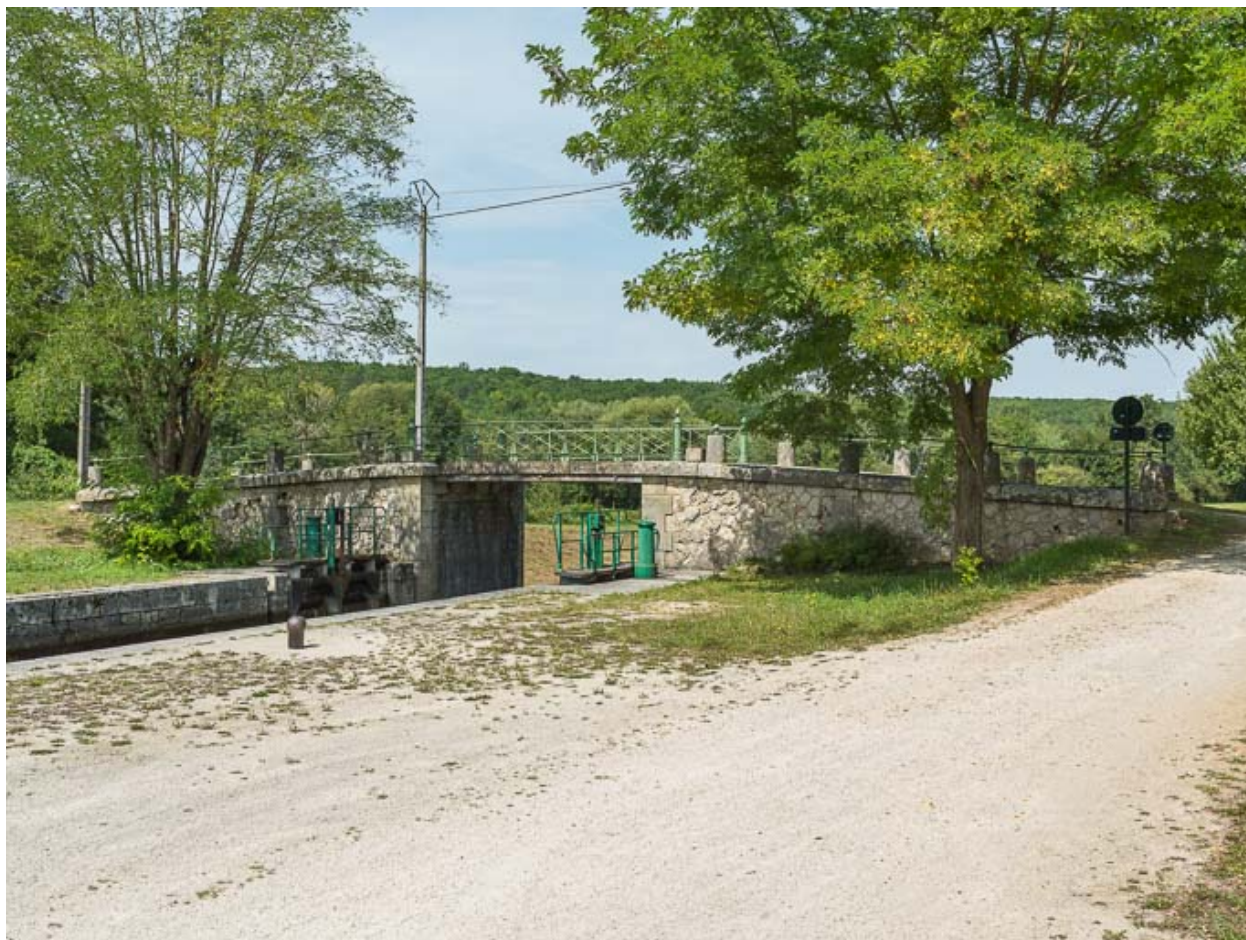
Vue d'ensemble du pont.
