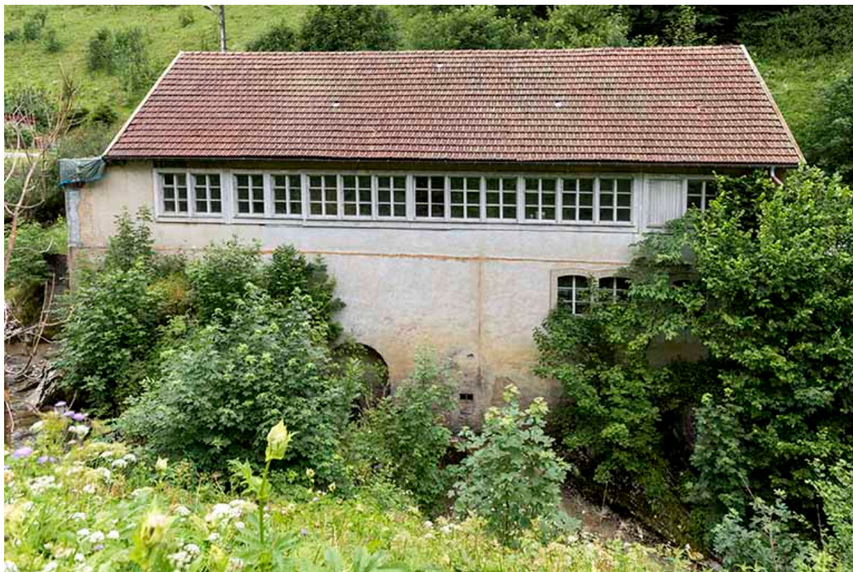
Usine : façade postérieure.
