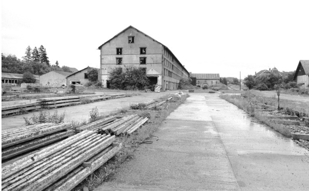
Vue d'ensemble depuis l'ouest en 1980.SRI. Enquête régionale sur les bâtiments industriels (1979-1981).
