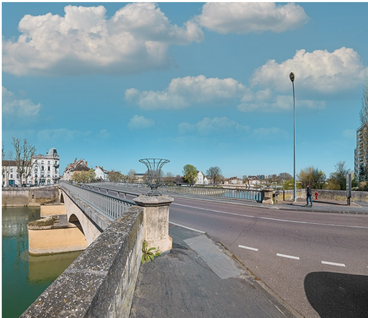
Vue d'ensemble du pont depuis la chaussée.
