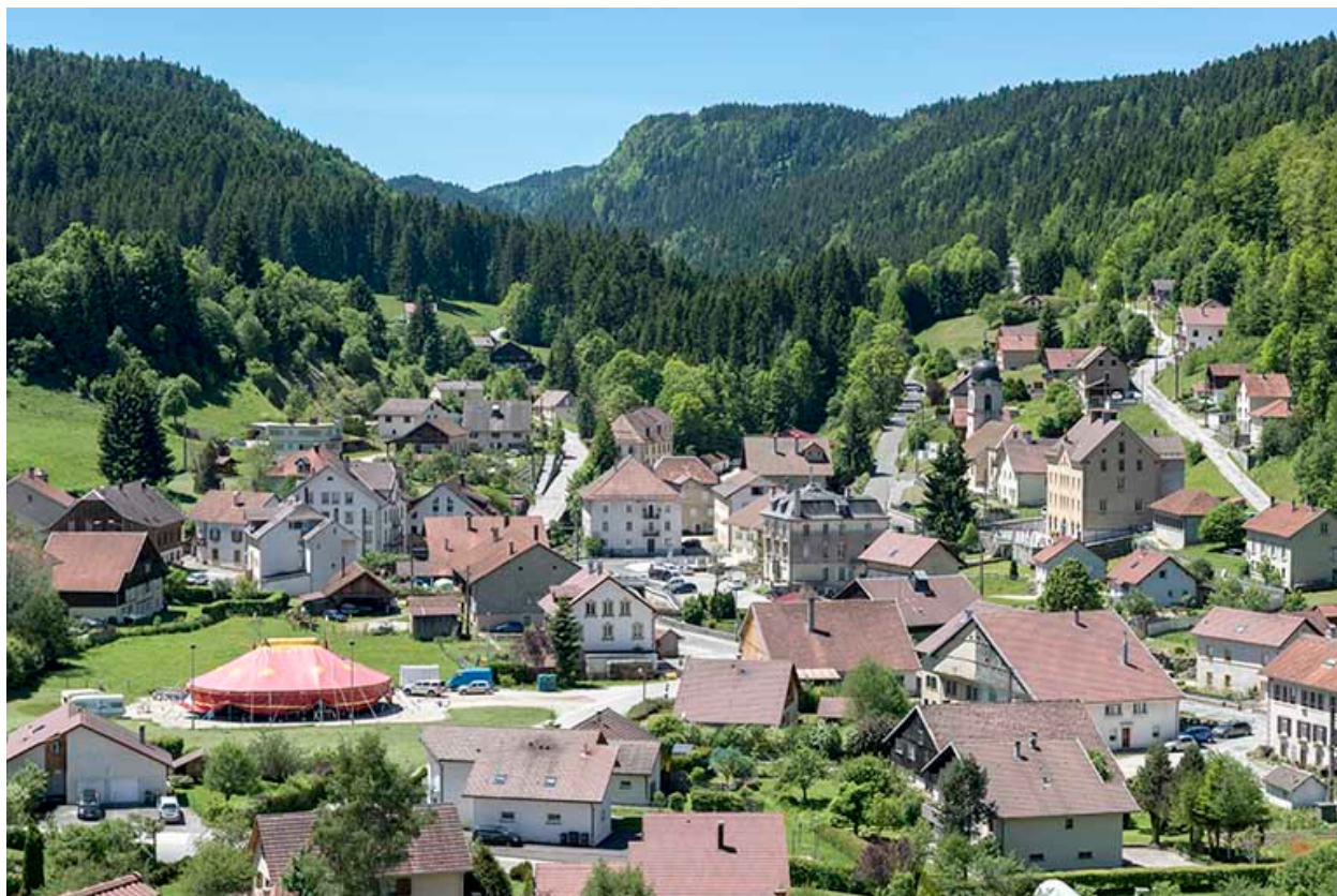
Vue d'ensemble du village, depuis le nord-est.
