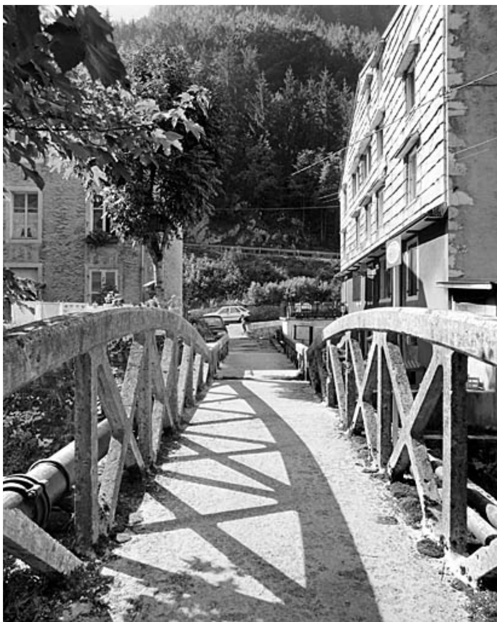
Tablier et garde-corps, depuis la rive droite.
