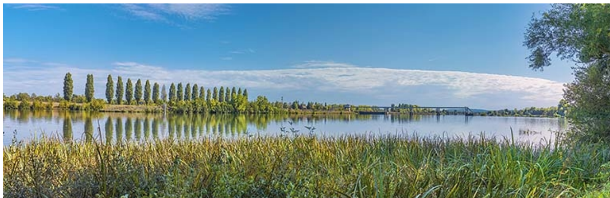
Le barrage, vu d'amont.
