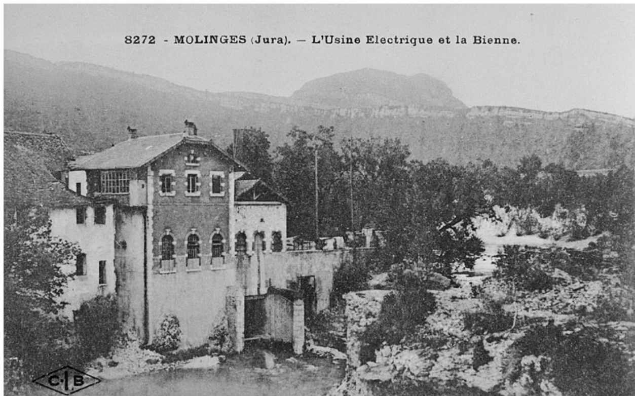
Molinges (Jura). - L'Usine Electrique et la Bienne.
