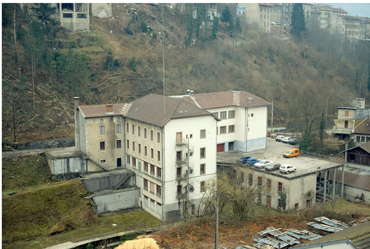
Vue d'ensemble plongeante depuis le nord.
