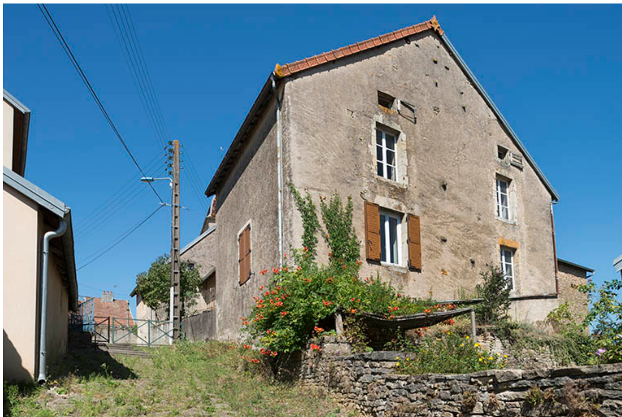
Le mur pignon côté sud.
