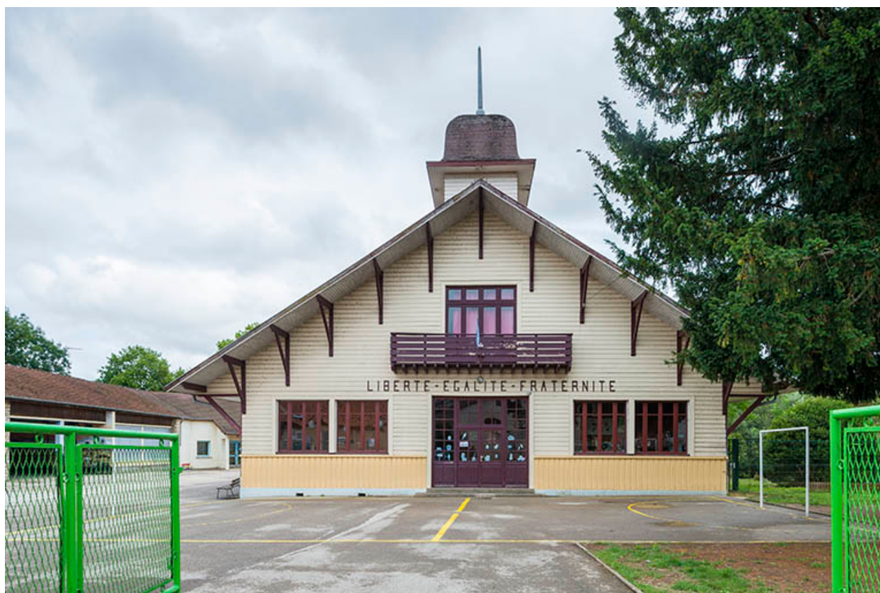
La façade principale.
