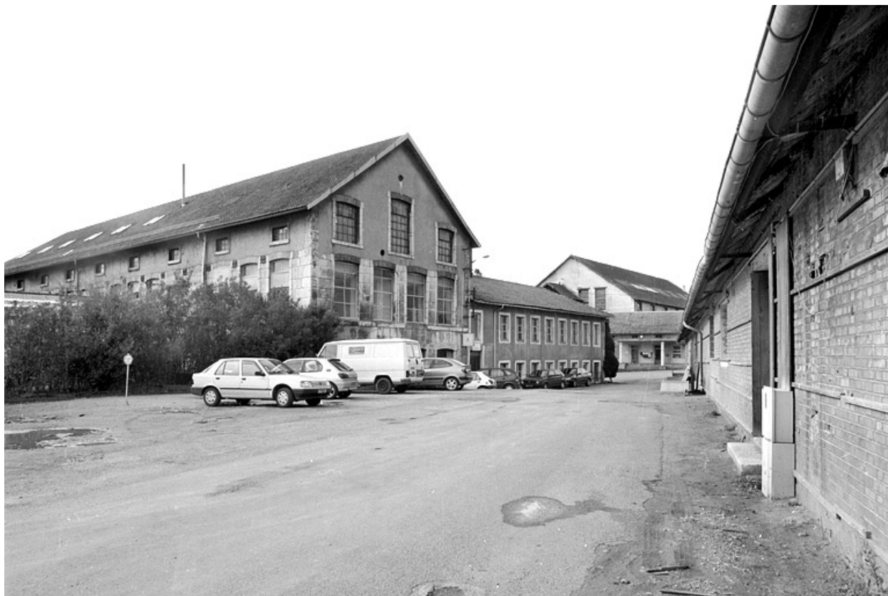
Atelier de fabrication et bureau depuis l'est.
