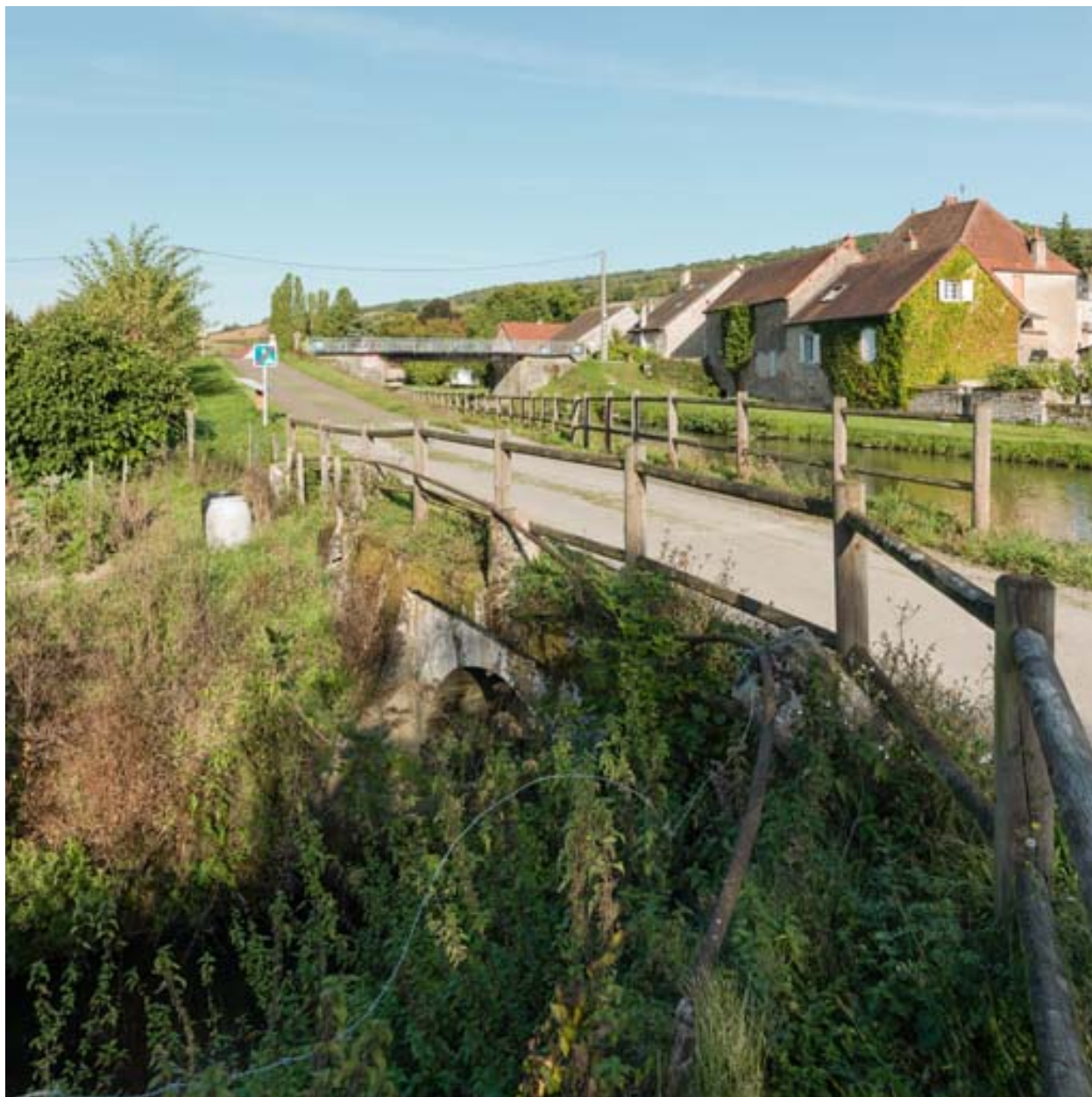
Vue de l'aqueduc.
