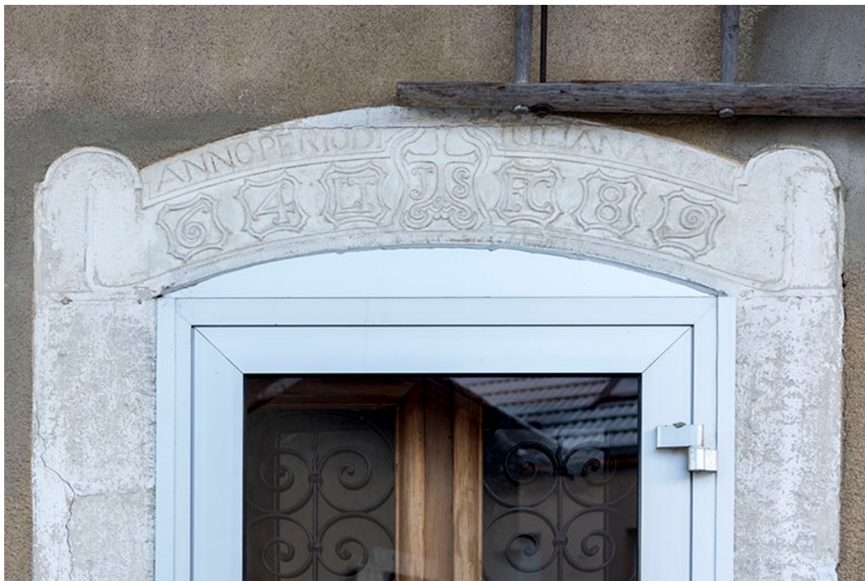
Façade antérieure : linteau avec inscription et datation.
