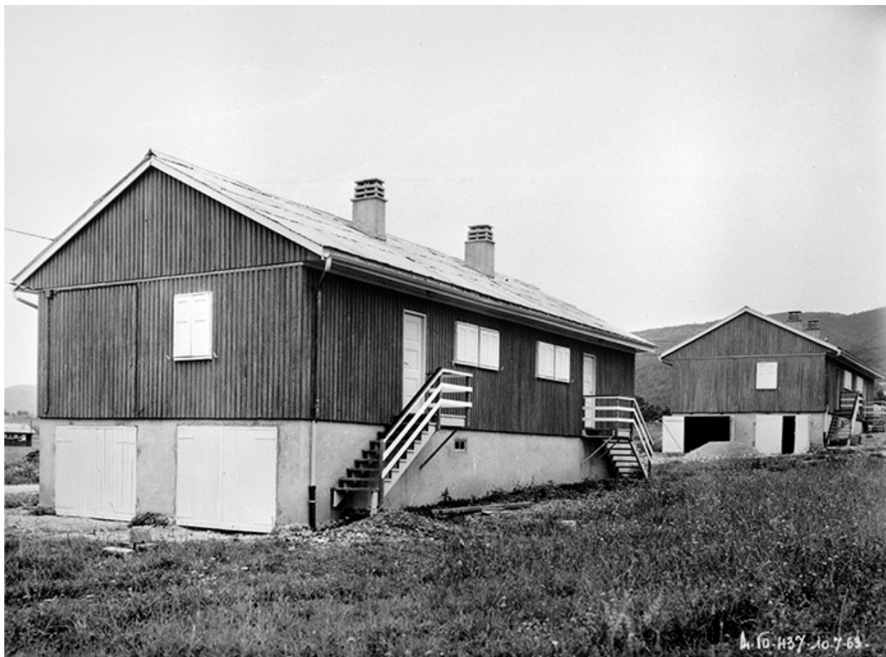
Cité de Vouglans. Logements R.B.M.
