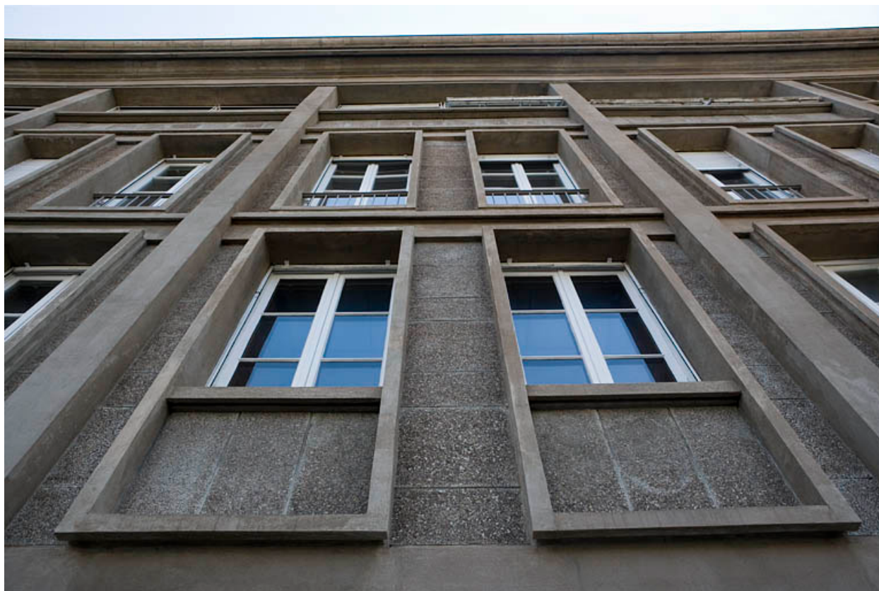
Face latérale droite : fenêtres vues en contre-plongée.
