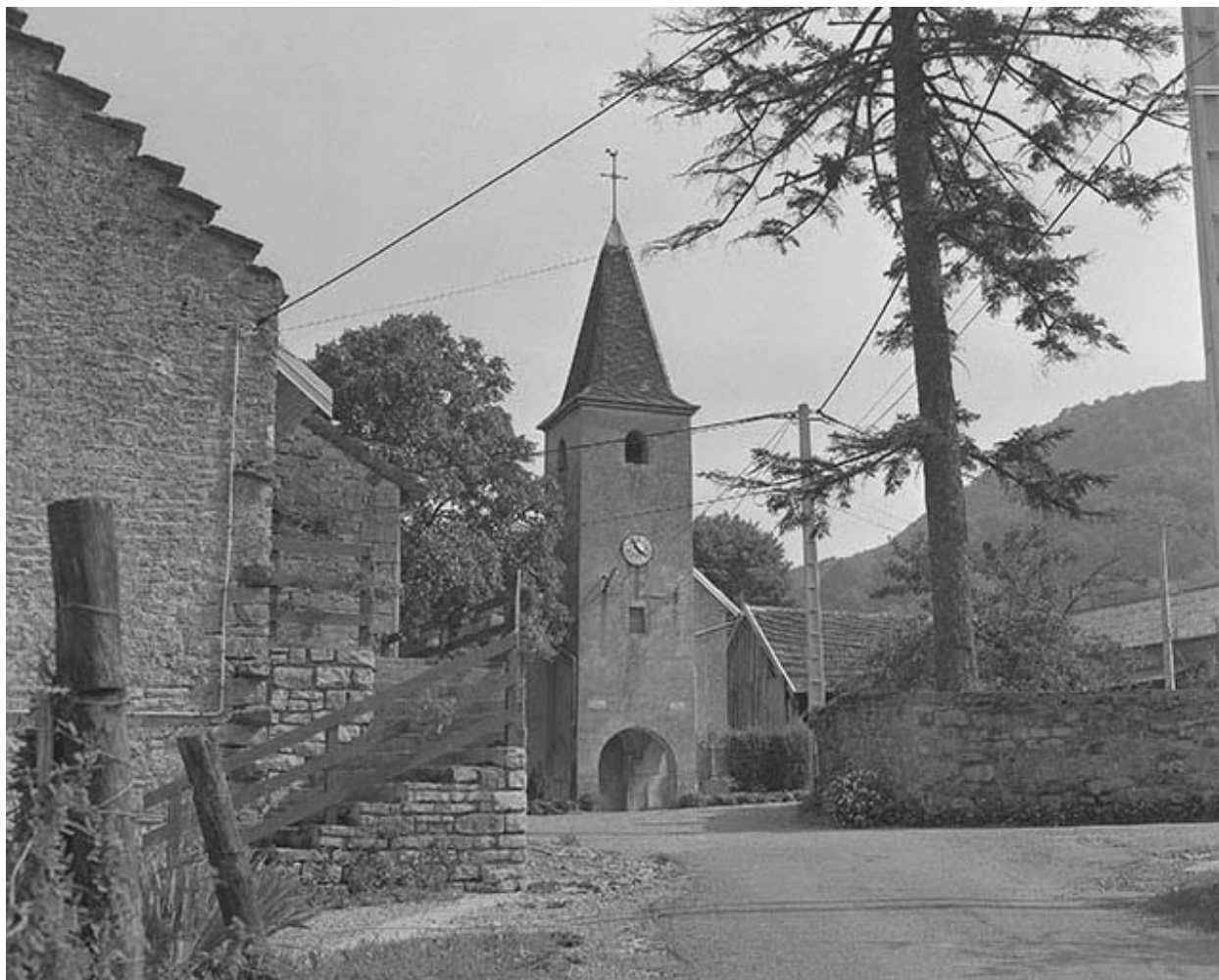
Extérieur : façade antérieure.
