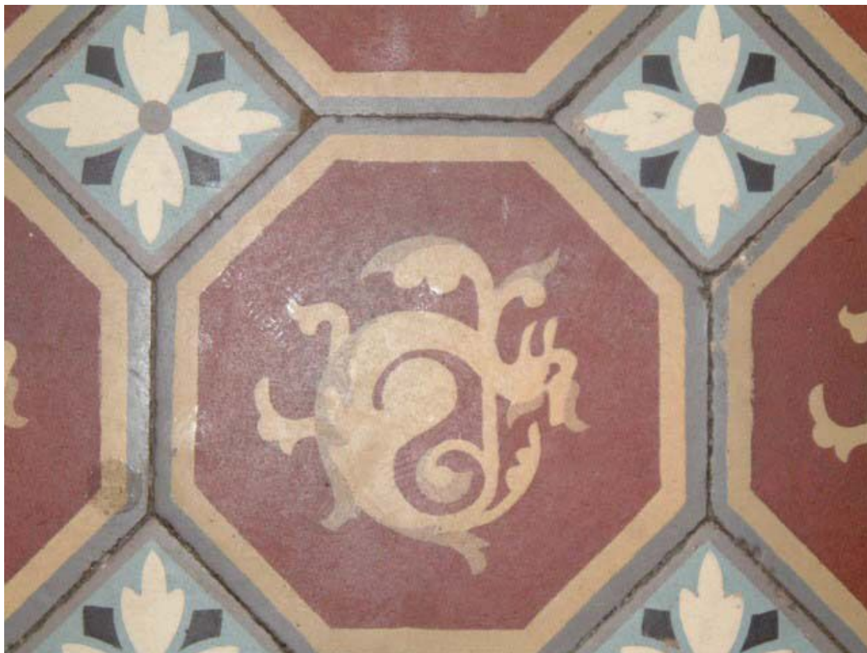
Vue de détail du carrelage du rez-de-chaussée.
