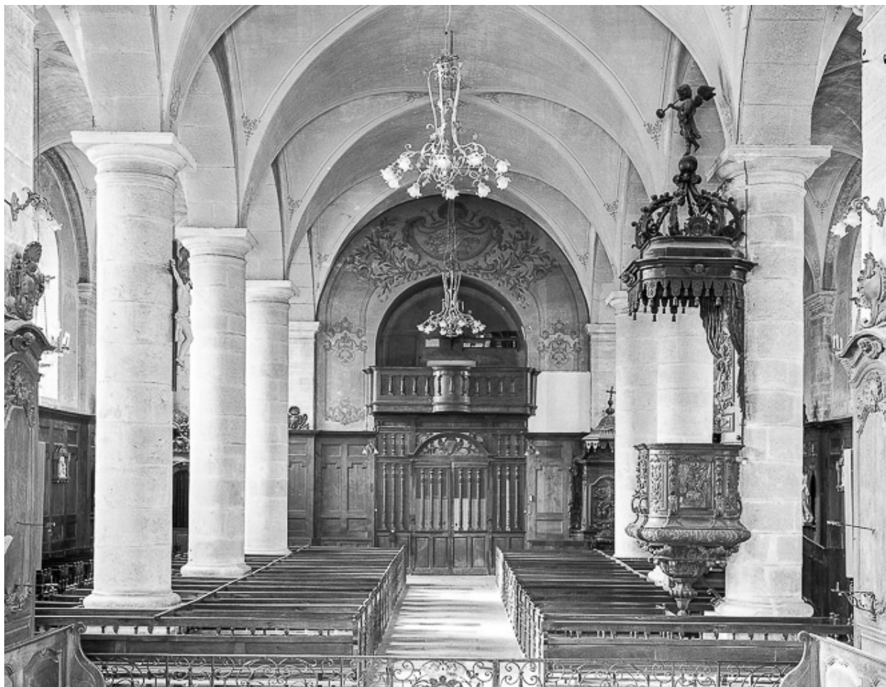
Nef vue depuis le chœur.
