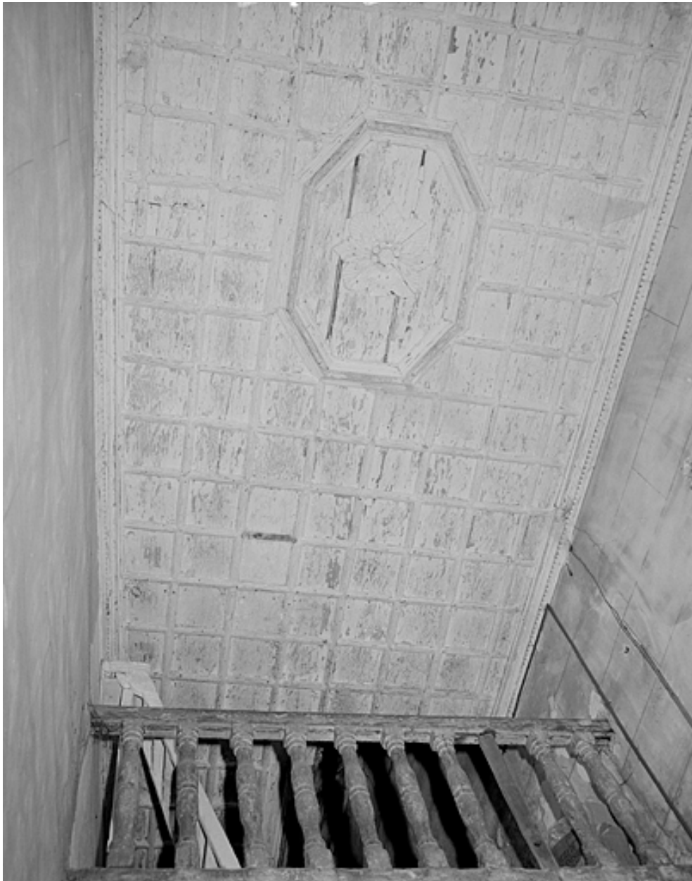
Escalier, plafond à caissons.
