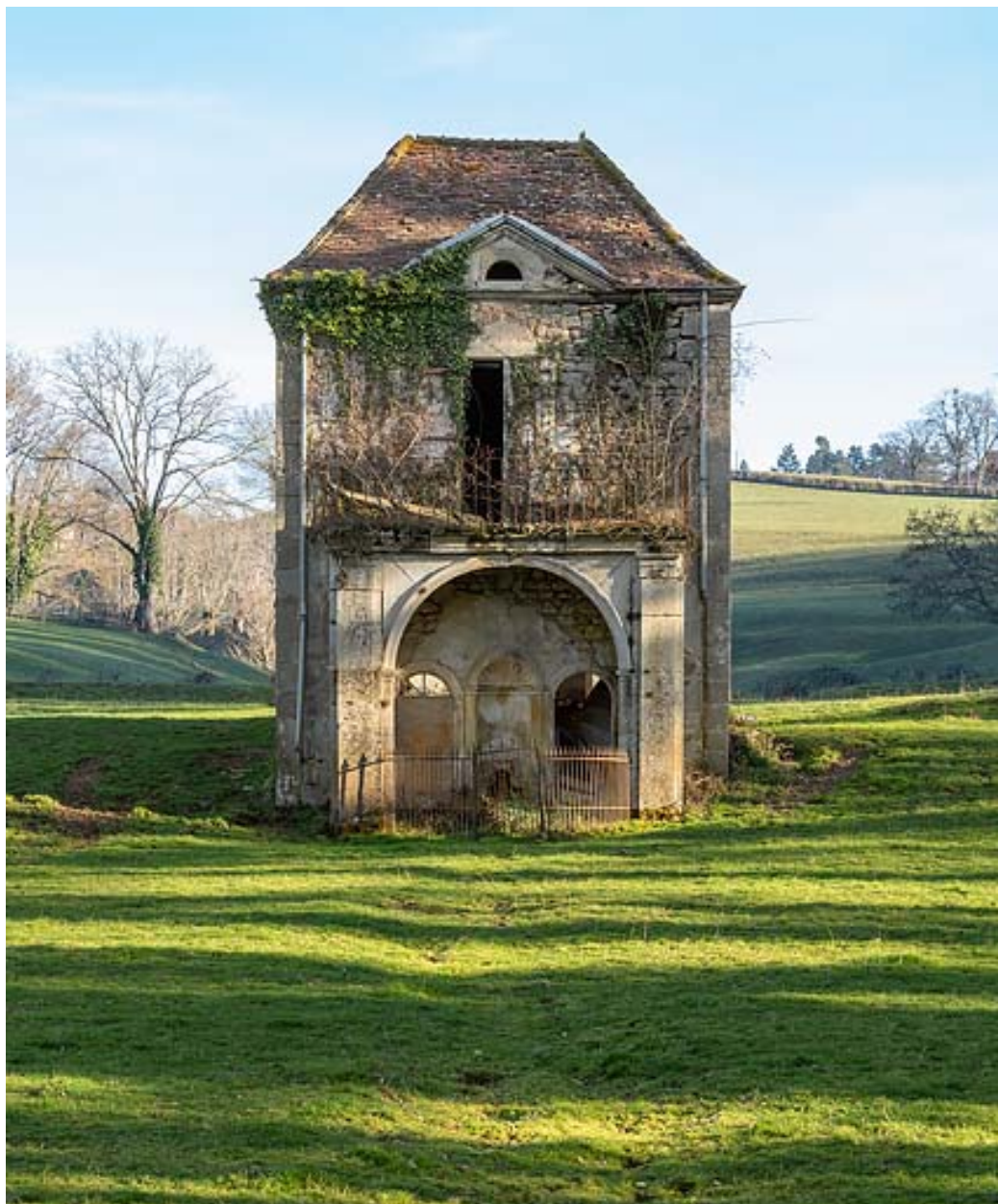
Pavillon de la source, vue de face.
