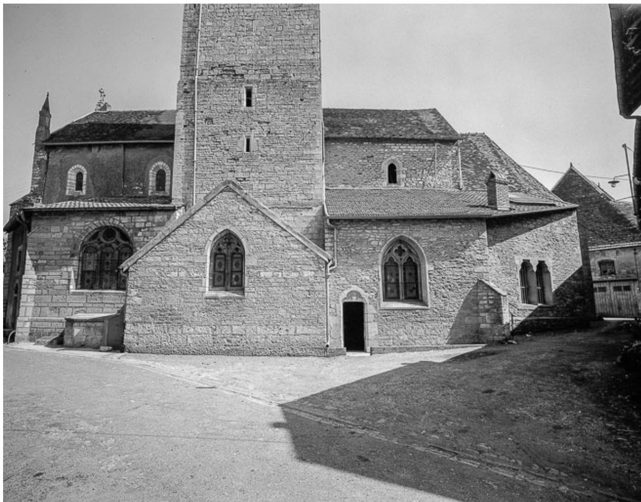
Façade latérale droite.
