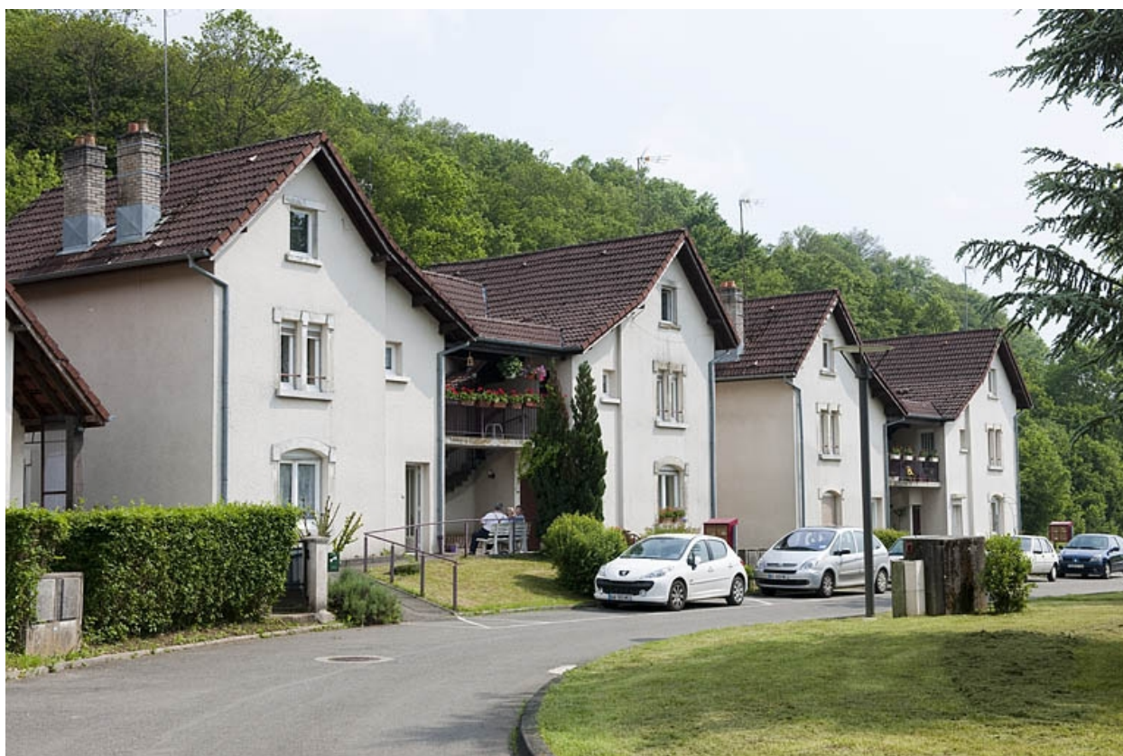
Cité du parc. Habitations de 4 logements.
