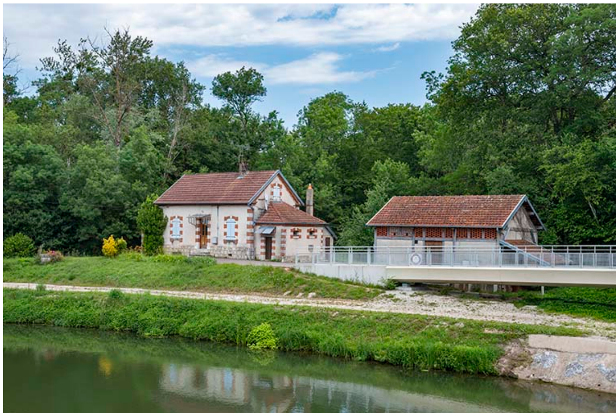
Maison du barragiste à Apremont (70).
