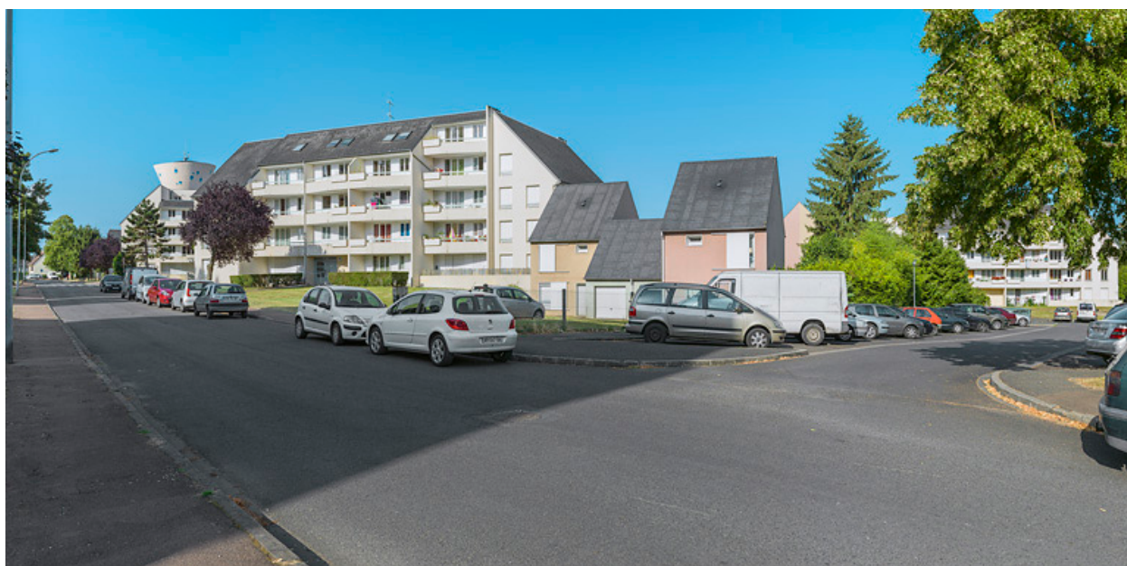
Les Hauts de Loire, vue générale.
