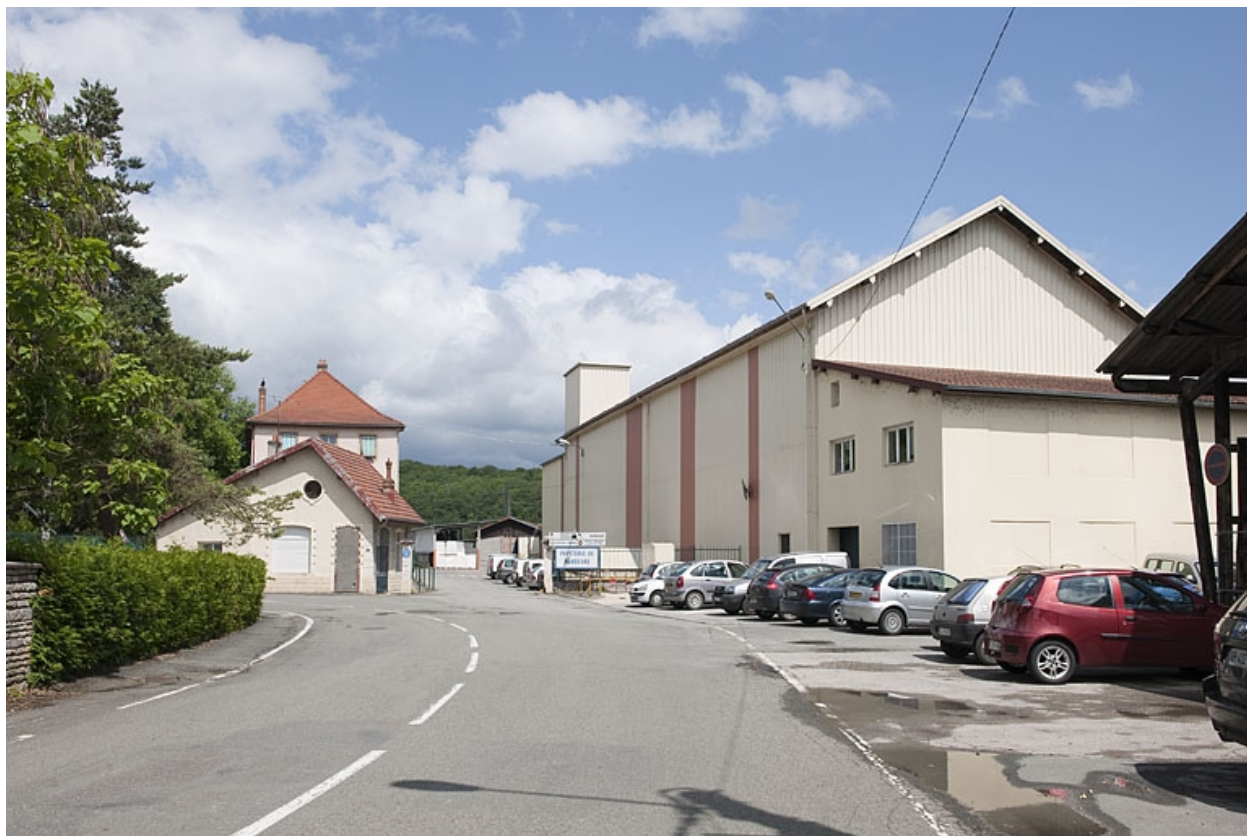
Vue d'ensemble de l'entrée de la papeterie.
