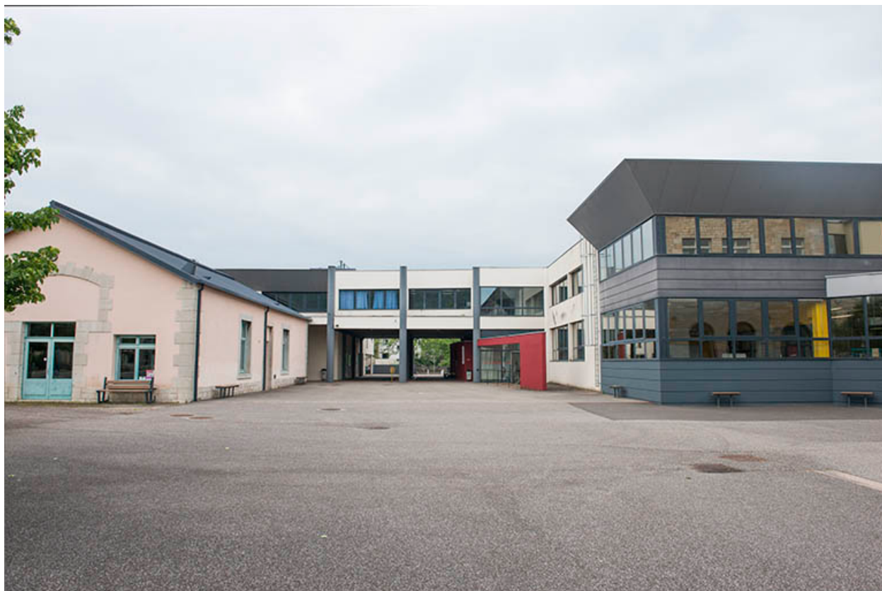
Façade postérieure de l'entrée, ateliers.
