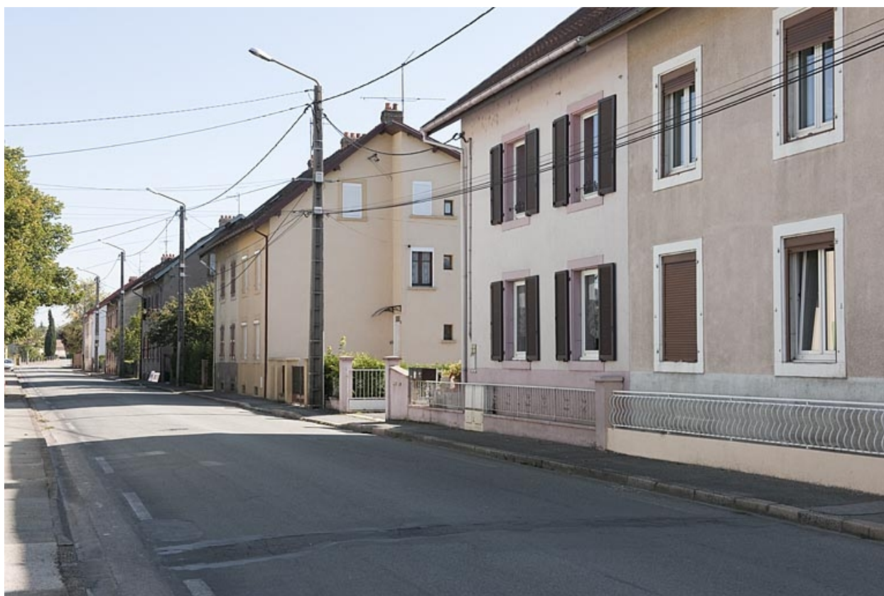
Façades antérieures sur la rue des Mines.
