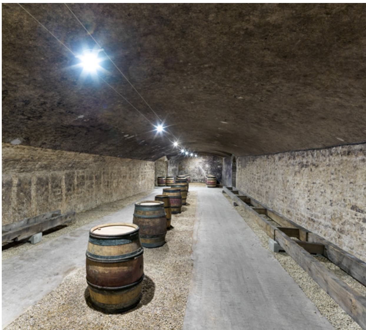
Caves, rez-de-chaussée : vaisseau central.
