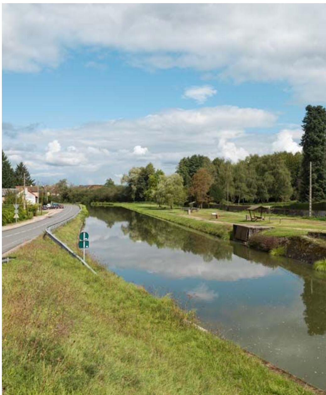
Vue d'ensemble du port.
