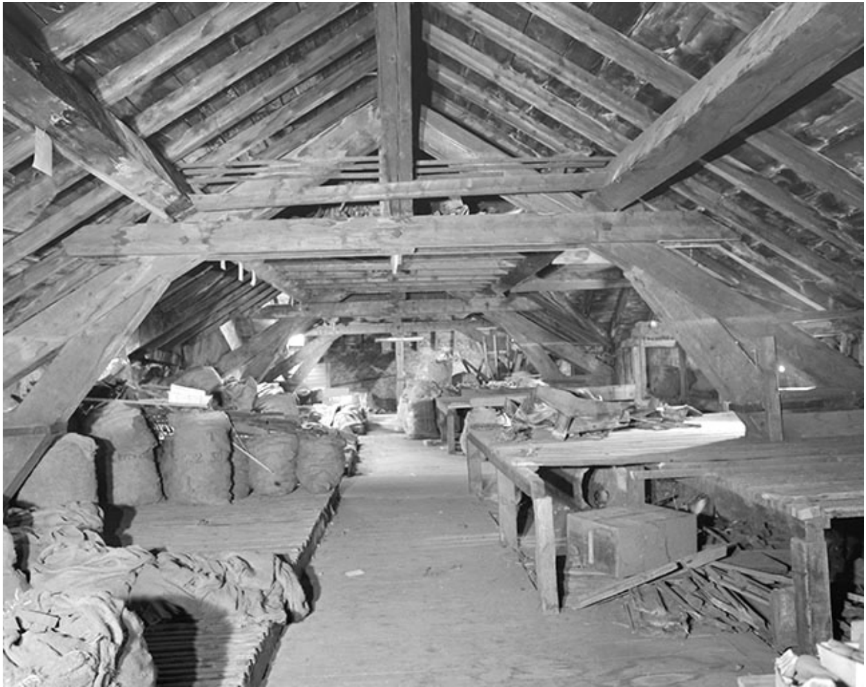
Intérieur d'un séchoir à ébauchons (bâtiment ouest).
