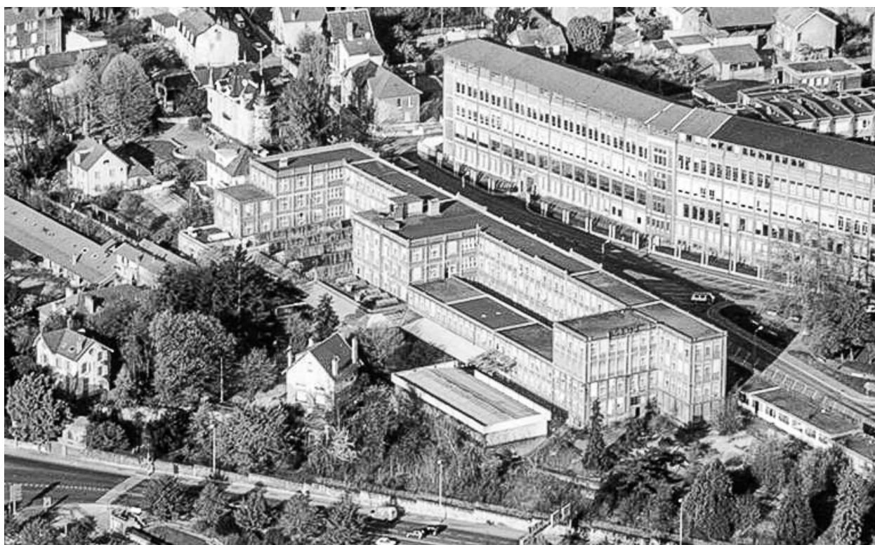
Vue aérienne de l'usine, depuis l'est.
