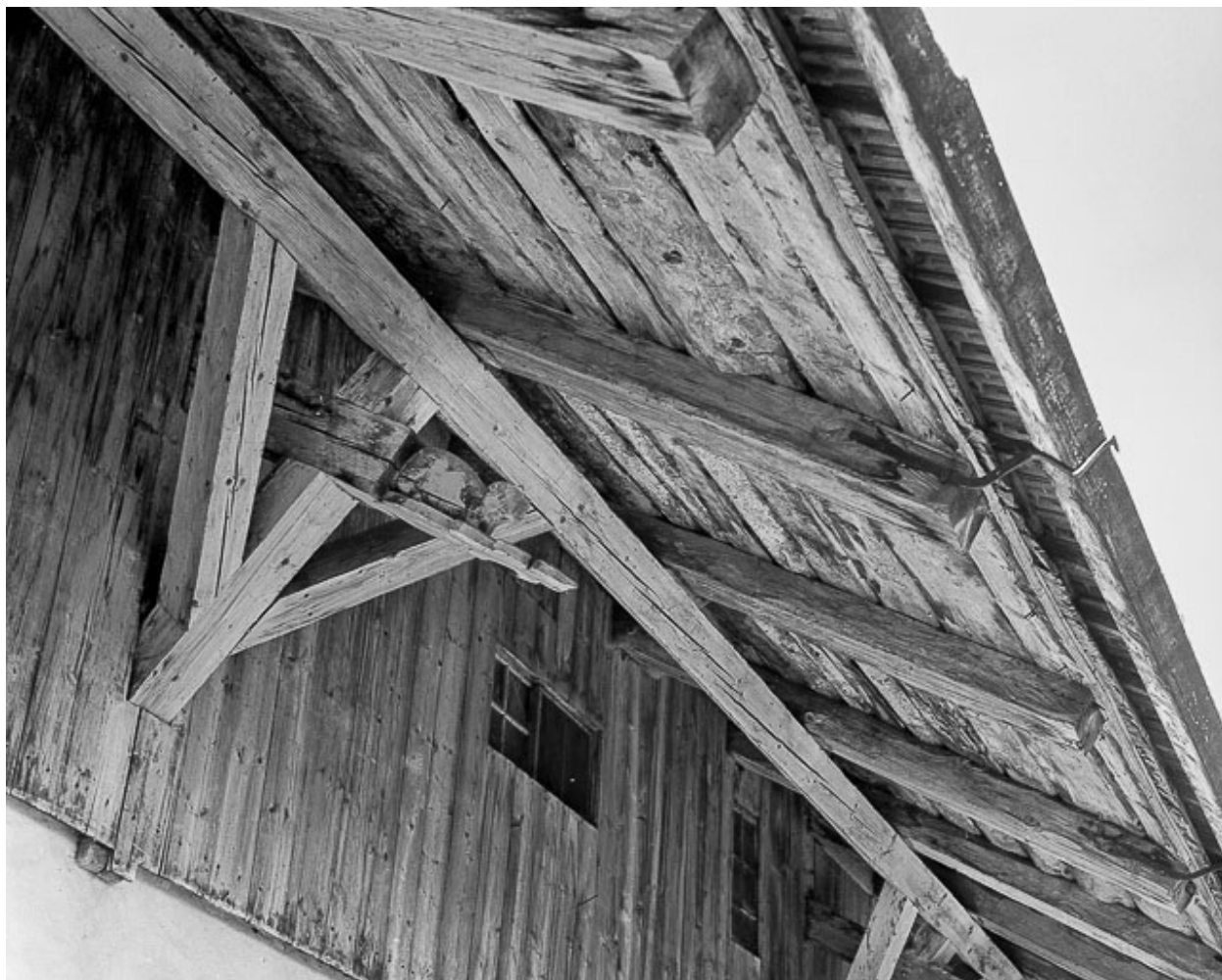
La ferme en 1976, arbalétriers côté nord : chat (2e) ?
