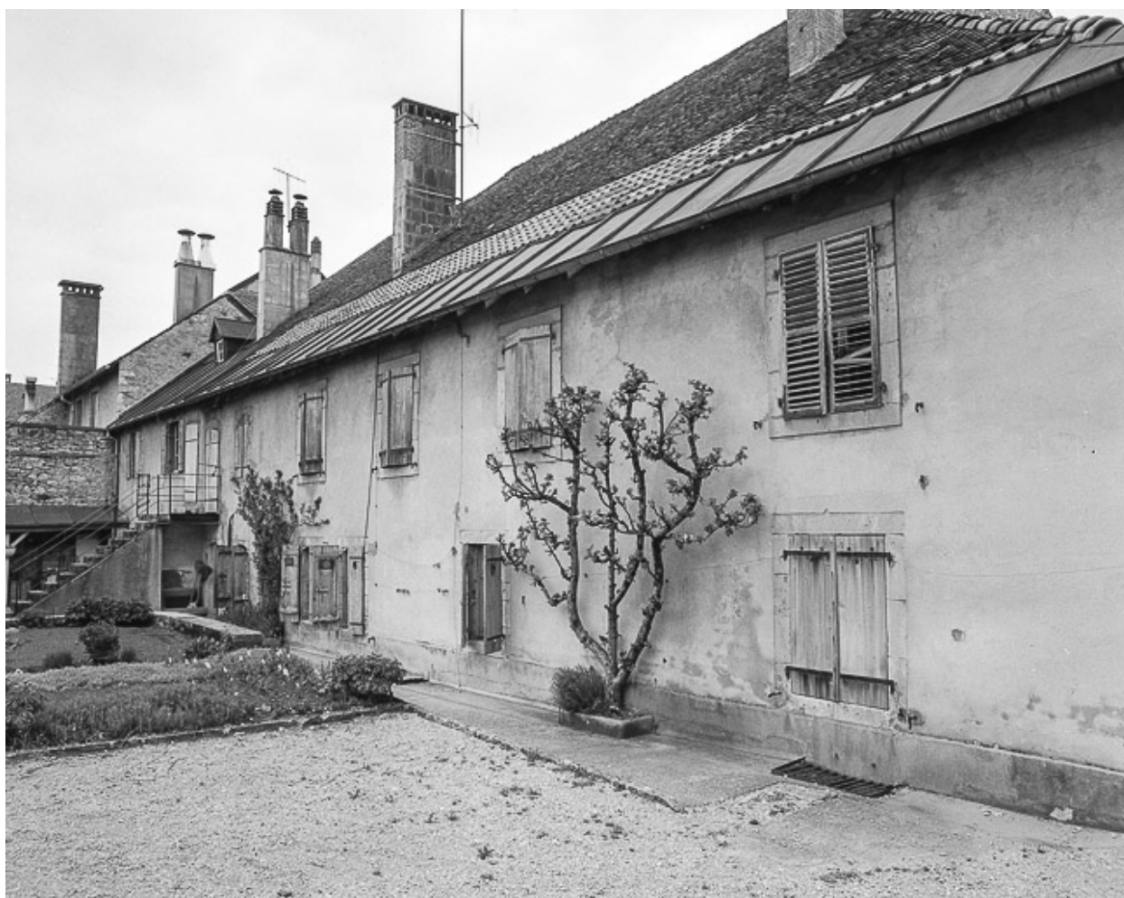
Façade postérieure (habitation).
