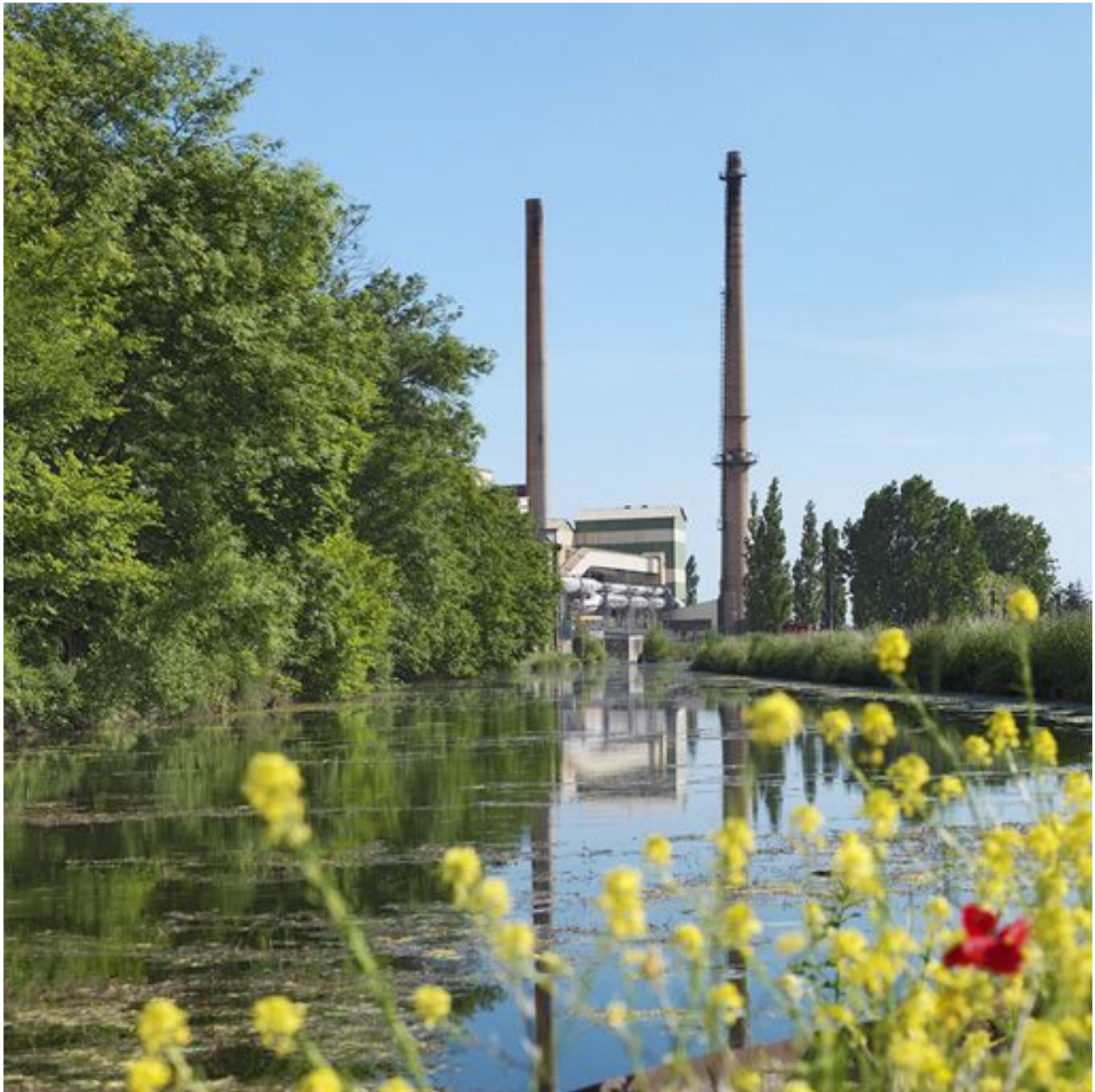
Vue générale de l'usine depuis l'embranchement.
