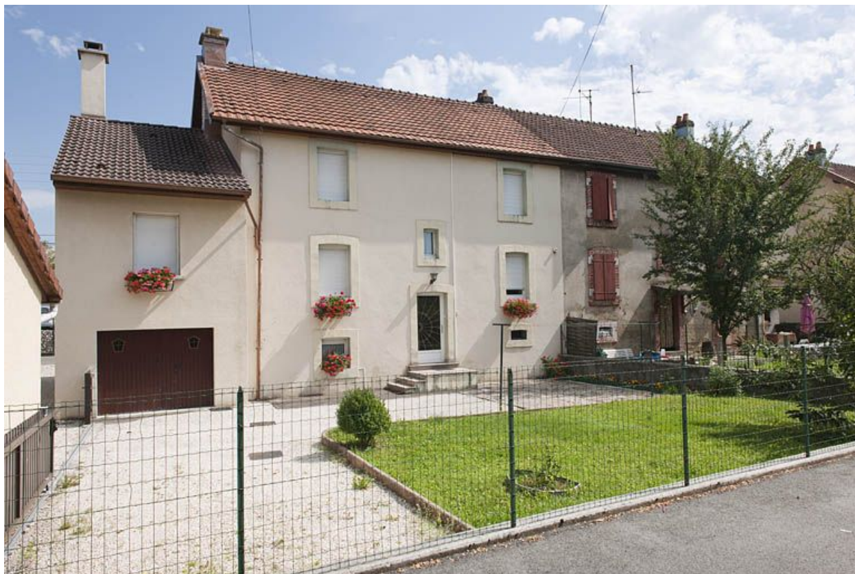
Rue de Verdun. Façade postérieure d'une habitation.
