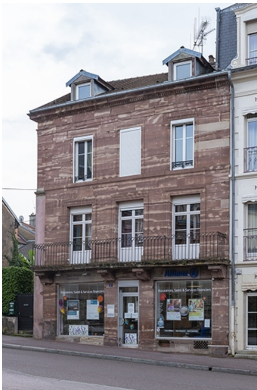
Façade sur la rue des Thermes.
