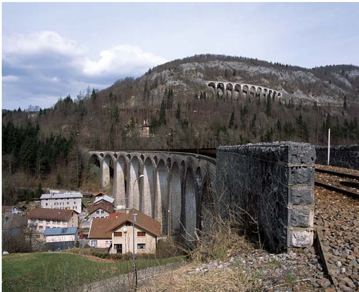
Parapet sud de la culée côté Andelot-en-Montagne.
